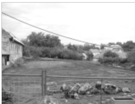
Stavba nového hřiště
